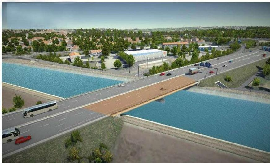
Ces travaux, d'une grande complexité, impliquent la démolition complète du tablier sud du pont existant et son remplacement intégral. Une grue colossale de 77 mètres de hauteur et d'une portée de 70 mètres sera déployée pour manipuler les éléments clés du chantier, notamment des charpentes métalliques pouvant atteindre le poids de 120 tonnes chacune.
