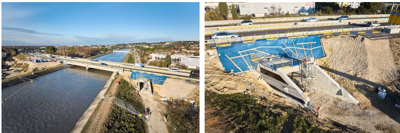
Allongement de l'ouvrage rue Conrad Chastel passant sous l'autoroute A54
