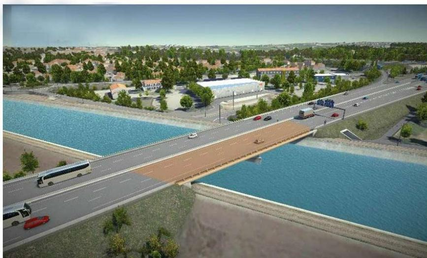
Ces travaux, d'une grande complexité, impliquent la démolition complète du tablier sud du pont existant et son remplacement intégral. Une grue colossale de 77 mètres de hauteur et d'une portée de 70 mètres sera déployée pour manipuler les éléments clés du chantier, notamment des charpentes métalliques pouvant atteindre 120 tonnes chacune.
