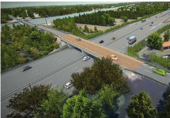
Le pont de la RD68 avant les travaux
