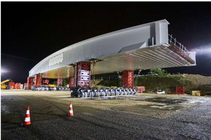
*Le déplacement de la charpente jusqu'à sa zone d'appui définitive le
