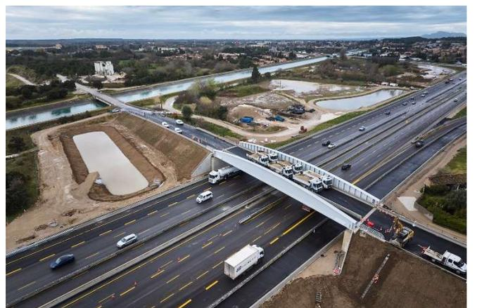
*La réalisation des épreuves de chargement sur le nouvel ouvrage
